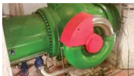
Una de las cuatro válvulas esféricas de vuelta a su sitio, luego de la renovación
