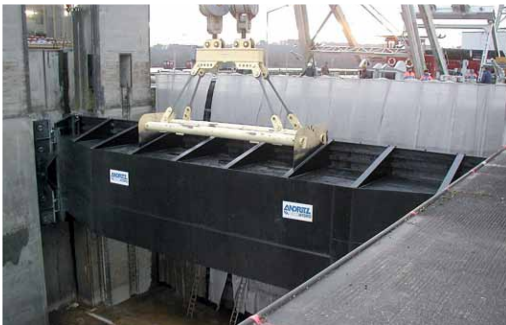
t Montaje de compuerta de doble gancho en la CH Wallsee Mitterkirchen, Austria
