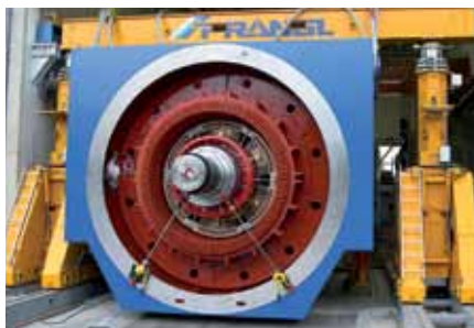
Generador de 180 ton de peso, siendo movido hacia el interior del edificio usando rieles móviles
