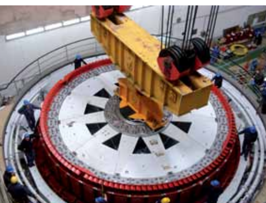
t Rotor del generador descendiendo a su posición final
