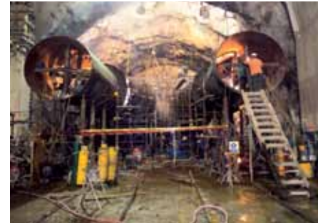
§ Supervisión en sitio del montaje de la bifurcación
