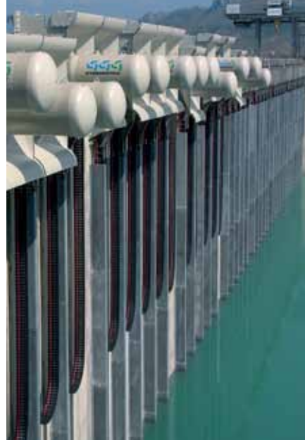
5 Unidades Turbina-Generador en posición de mantenimiento
