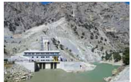
▲ La centrale vue depuis l'aval avec la rivière Ceyhan
