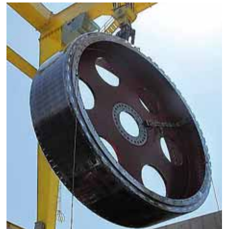
▲ L'installation du rotor d'alternateur
