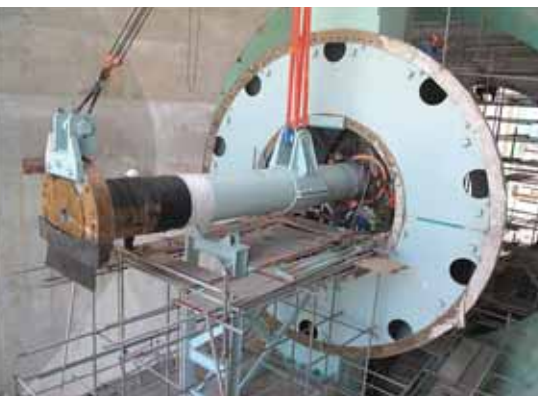
▲ Installation d'un axe
