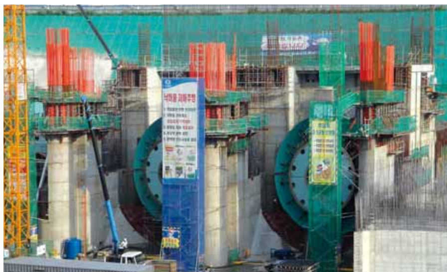
▲ Les bâtis des turbines Bulbe sont scellés dans le béton
