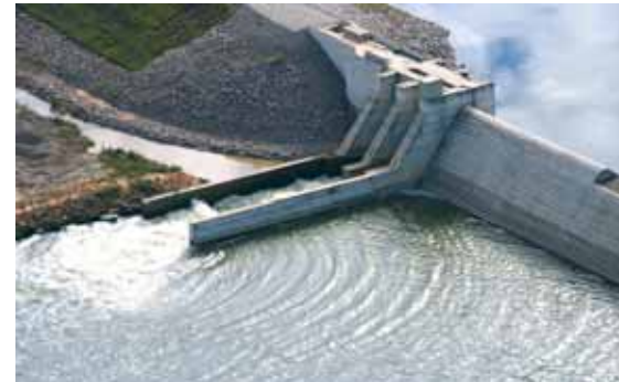
▲ Vue aérienne de la centrale hydroélectrique de Rondon II
