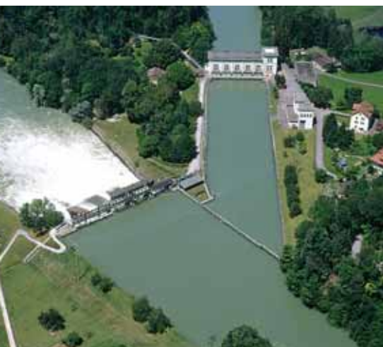
▲ La centrale existante de Hagneck, avec le pont digue
