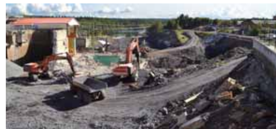
▲ Démolition de l'ancienne centrale et du barrage
