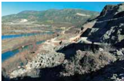
▲ Les activités sur le site de construction de Pembelik à l'entrée du tunnel de diversion
