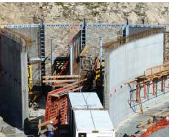
▲ Installation des grilles à débris dans les structures aval et amont
