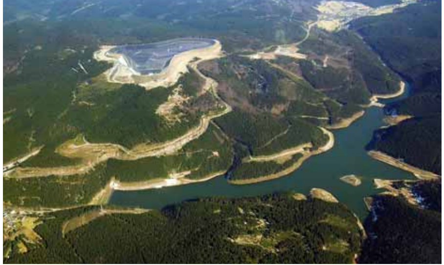
▲ Vue aérienne de la centrale de pompage turbinage de Goldisthal, en Allemagne
