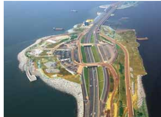
▲ Les derniers travaux sur l'île artificielle
