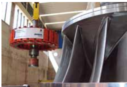
▲ Installation du rotor d'alternateur de Rondon II
