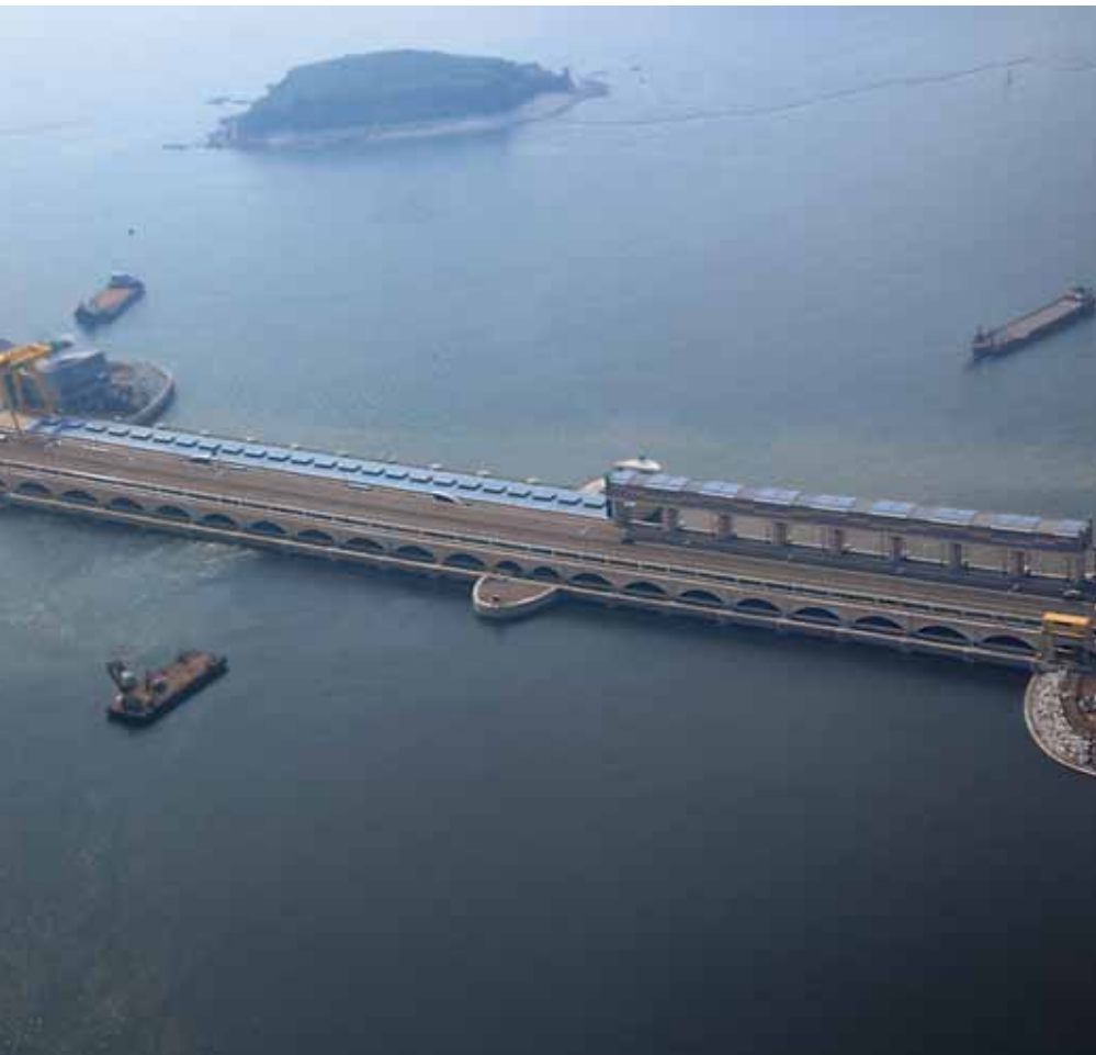
▲ Vue aérienne de la centrale et de la digue
