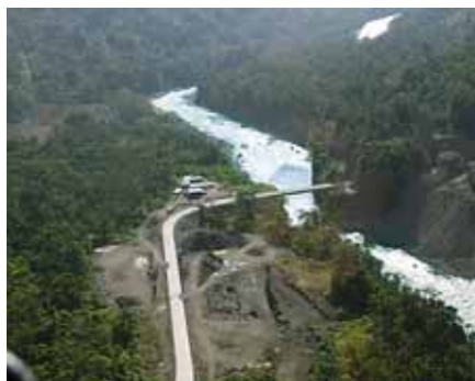
▲ L'équipement de production sur la rive droite
