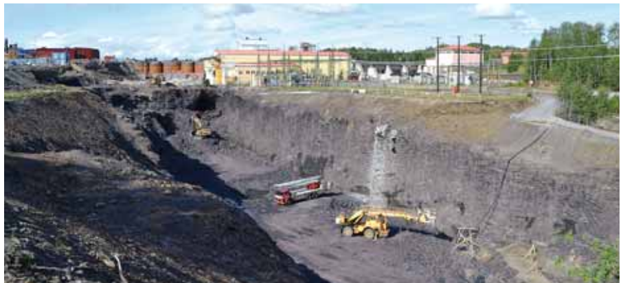
▲ L'entreprise de génie civil creuse un nouveau canal aval
