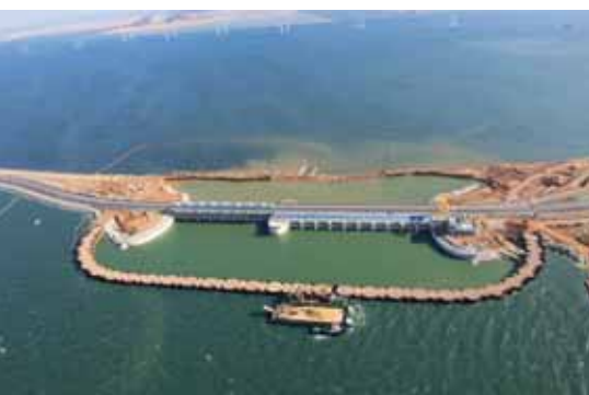
▲ Après la mise en eau, les palplanches sont retirées
