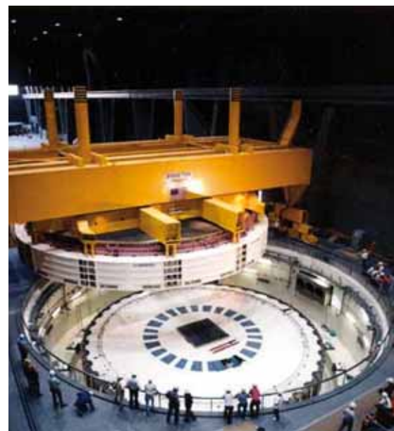
▲ Installation du rotor de Grand Coulee
