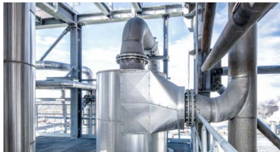
新的排气处理系统保证了安全性以及木片仓的无臭气运行。
