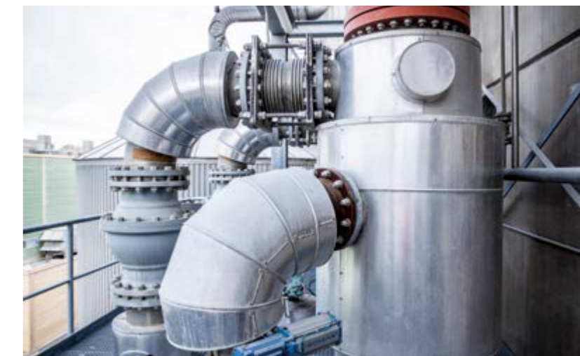
预浸药液的预加热器是热优化系统的组成部分。
