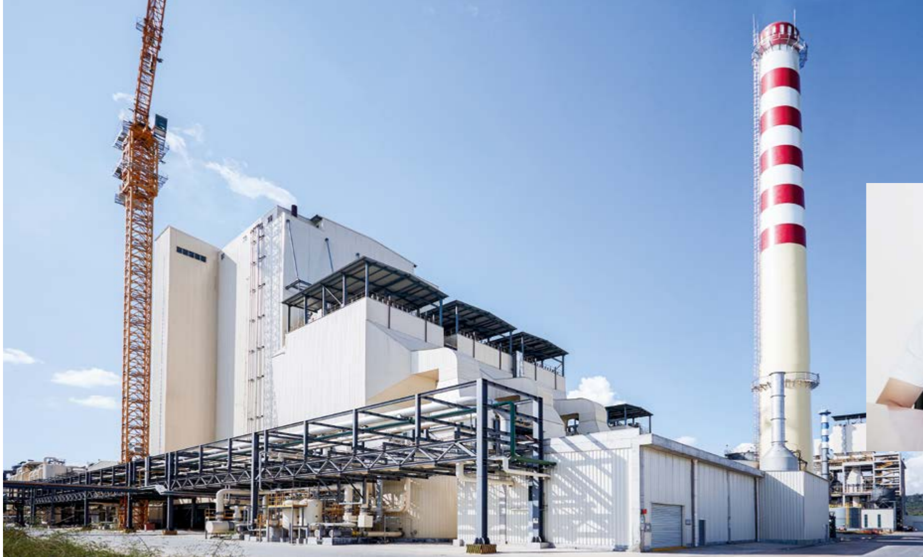
安德里茨为工厂交付了老挝最大的高效碱炉，能力为2200 tds/d, 旨在安全和稳定的运行。
