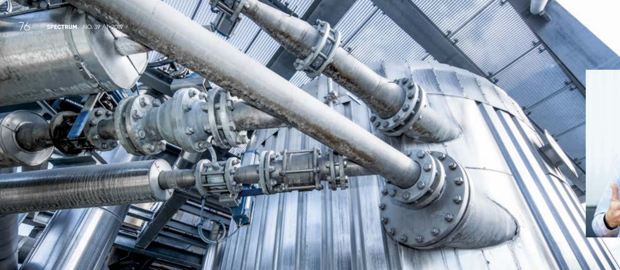
黑液在全新的采用安德里茨FlashLance™技术的高效闪蒸罐内进行闪蒸。
