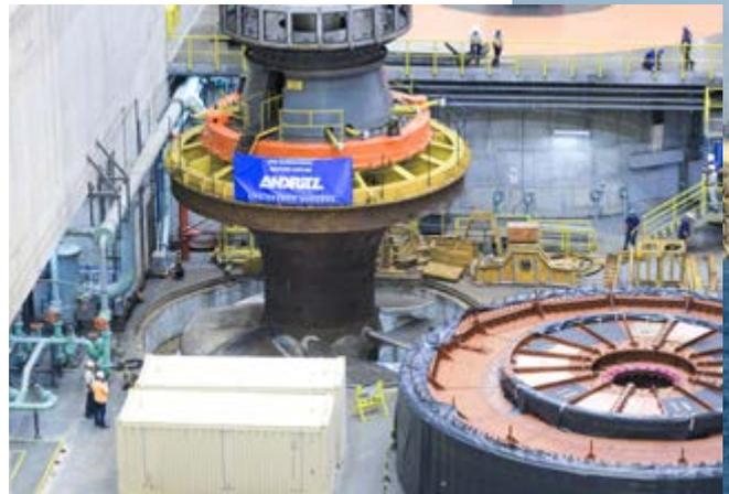
Vue de l'extérieur (à droite) et travaux d'installation de la turbine Kaplan (en haut) dans la centrale hydroélectrique de Sobradinho sur la rivière São Francisco
