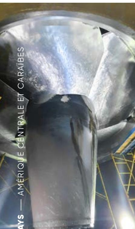
Installation de la roue de turbine dans la centrale hydroélectrique 15 de Septiembre, El Salvador
