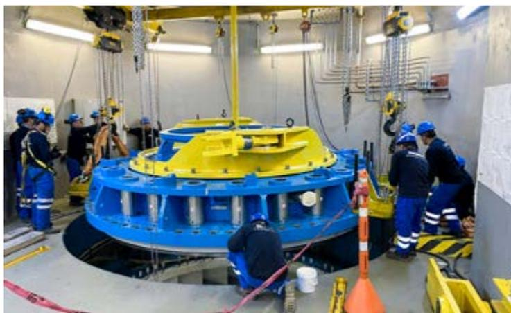
Installation de la vanne de garde de la centrale hydroélectrique de Cerro del Águila
