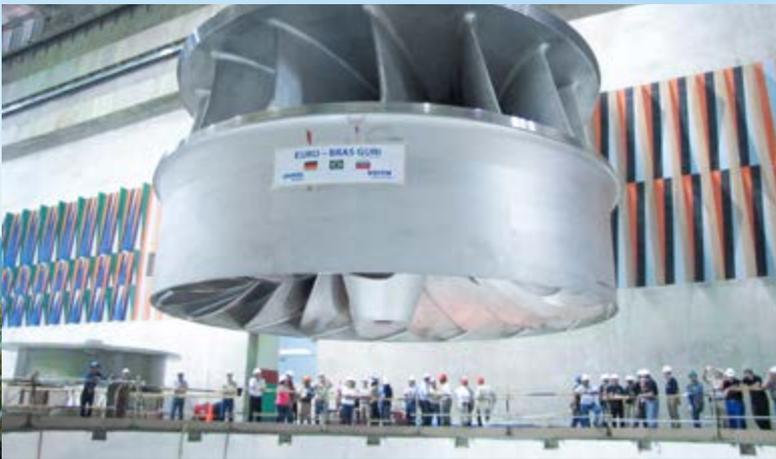
Instalação de um dos maiores rotores Francis do mundo (770 MW) na usina hidrelétrica Simón Bolívar "Guri"
