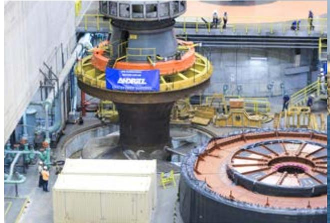
Vista externa (à direita) e trabalho de instalação da turbina Kaplan (acima) na usina hidrelétrica de Sobradinho, no rio São Francisco.
