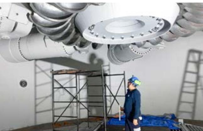
Rotor Pelton da usina hidrelétrica de Zimapán
